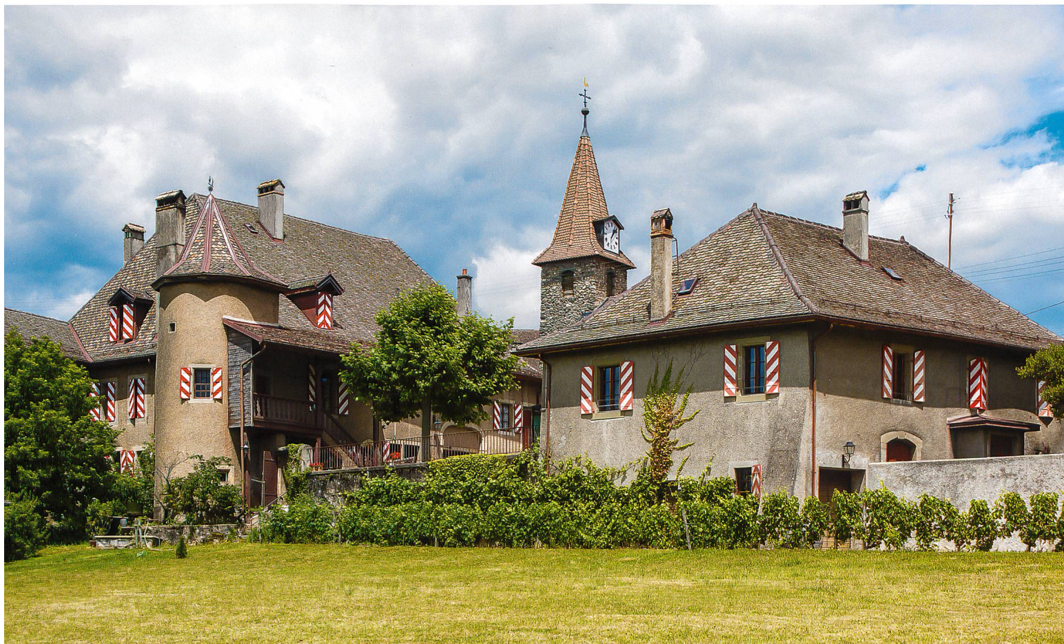
Fig. 4 Allaman, maison de Rochefort. Bâtiment construit avant 1515 par le notaire Louis Challet. Etat en 2014. Photo Adrien Barakat
