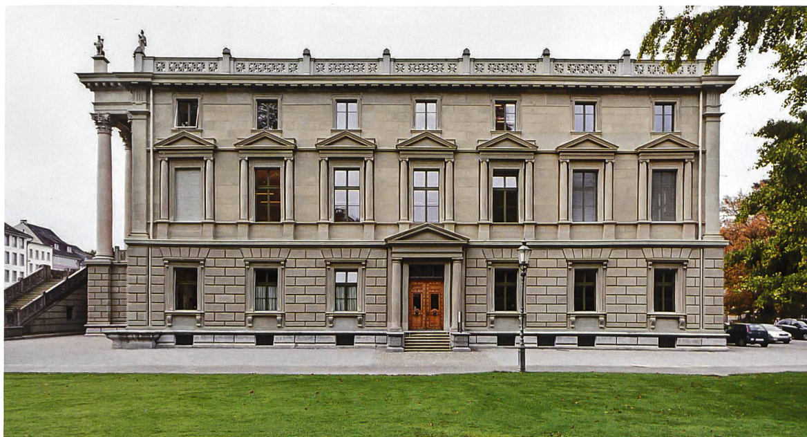
Stadthaus Winterthur, 1932–1934 um zwei Achsen verlängerte Seitenfassade mit in die neue Mittelachse versetztem Portal. Foto Michael Peuckert
