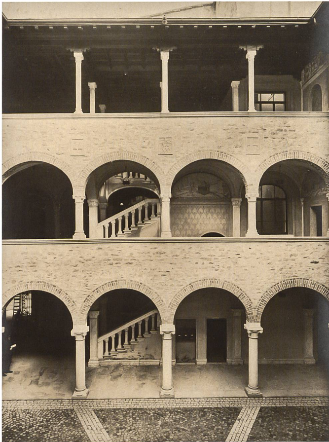
Abb. 4 Bellinzona, der Innenhof im neuen Palazzo Comunale von Enea Tallone, 1924/25, Aufnahme kurz nach Fertigstellung. Commissione delle Finanze del Consiglio Nazionale. Sopraluoghi nel Ticino dal 11 al 15 Luglio 1926, Hrsg.: Ufficio cantonale del Registro fondiario [Ticino], direzione
