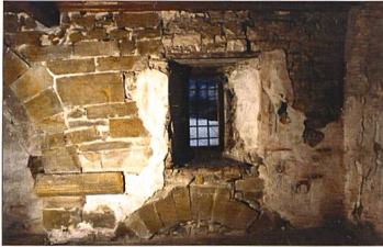
Abb. 230 Langenbruck. Ehemaliges Kloster Schöntal. Klosterkirche, Innenseite der Ostwand. Oberhalb des Zwischenbodens sind der mittlere ApSIDENbogen samt Kämpfer sowie die oberen Bogenkämpfer der rechten Nebenseite zu erkennen. Rechts davon hat sich – heute unter dem Putz verborgen – das Wandmalereifragment eines bärtigen Heiligen erhalten, das um 1450 datiert. Aufnahme um 1989, ABL.
