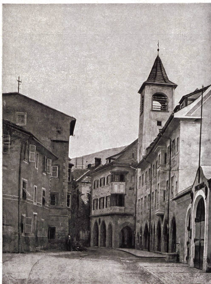
Abb. 133. Das neue Postgebäude (von Th. Fischer) in Hall in Tirol.
