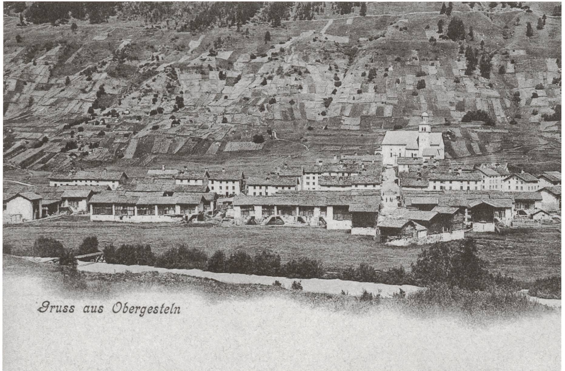
Abb.3 Obergesteln VS. Ansicht der nach dem Brand von 1868 in Steinbauweise nach rationellem Plan wieder aufgebauten Siedlung im Goms (Sammlung des Autors)
