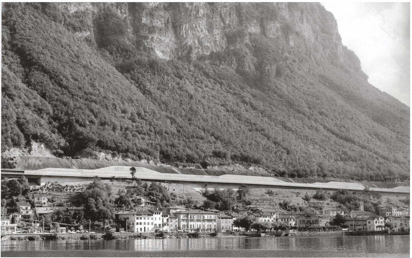
Muri di sostegno del tratto autostradale sopra Capolago. Archivio del Moderno. Fondo Rino Tami
