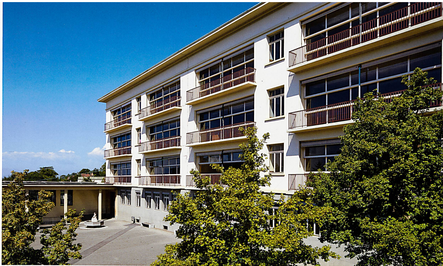
Fig. 3 École des Croix-Rouges, vue du sud-est. La façade de l'école se caractérise par sa symétrie et par ses larges fenêtres en bandeaux que les huisseries en guillotine permettent d'ouvrir très largement. Photo Jeremy Bierer, 2018
