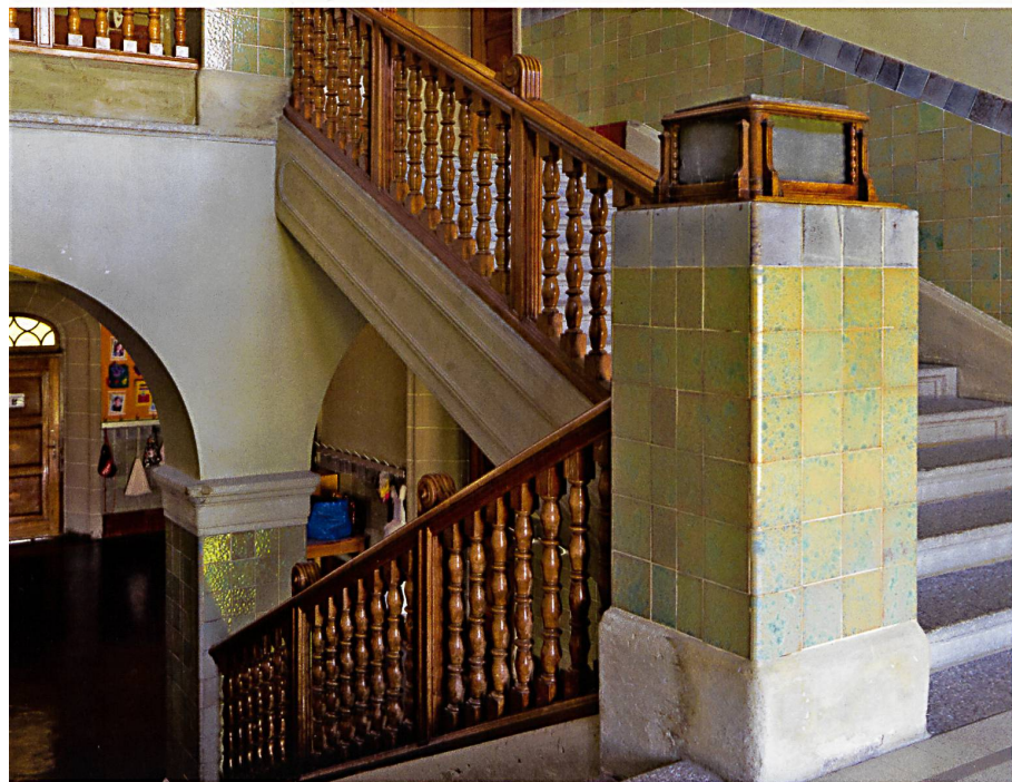
Fig. 2 Les espaces intérieurs de Montriond sont traités avec soin. La conception unitaire due à l'architecte G. Hämmerli permet aux arts appliqués de se déployer avec générosité; aux coloris des carreaux de grès vert d'eau répond le chêne massif du garde-corps et une jardinière destinée à abriter des plantes. Photo Davide Quattrocchi, 2012
