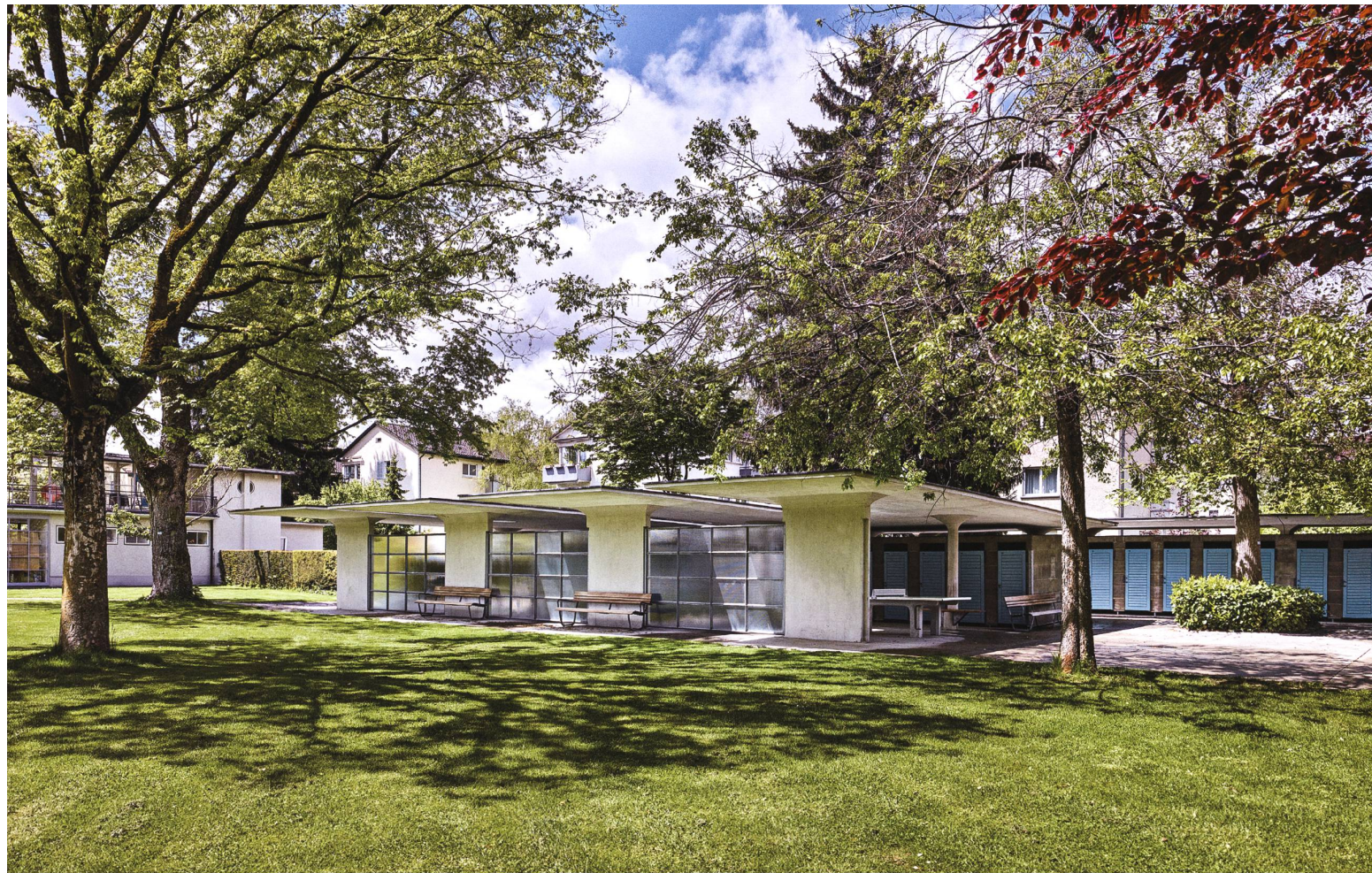
Teil der «Umkleideland-schaft»: Zwei Dächer mit kammartigen Einbuchtungen, auf schmale Wandstücke und Pilzstützen gelegt, überfangen Tisch-tennisplatten und Riegel von Einzelgarderoben. Foto Dirk Weiss
