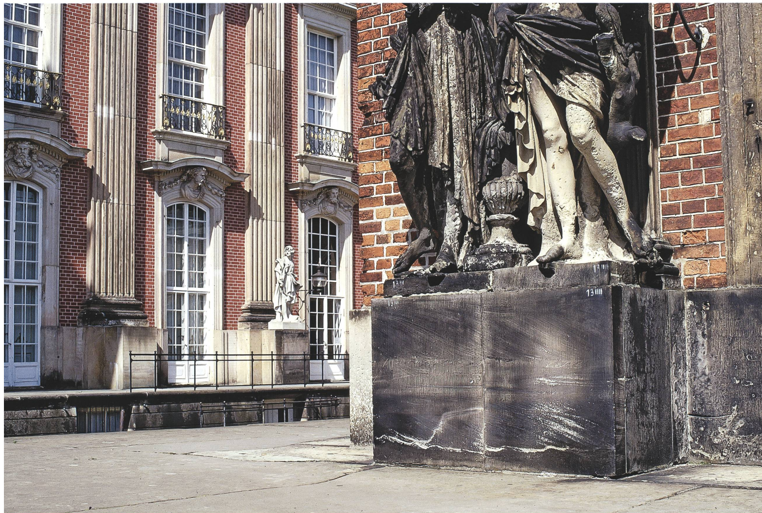
Abb. 2 Potsdam (D), Neues Palais, Johann Gottfried Büding, Heinrich Ludwig Manger, Carl von Gontard, 1763–1769: im Vordergrund echtes, im Hintergrund auf die Putzoberfläche aufgemaltes Backsteinmauerwerk. Foto M.F., 2003
