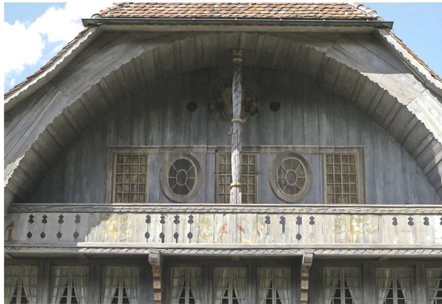
Abb. 11 Freilichtmuseum Ballenberg, Bauernhaus aus Ostermundigen BE, 1797: Detail der Giebelfront mit aufgemalten Trompe l'Œil-Fenstern. Foto M.F., 2020
