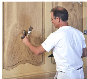
Holzimitationsmalerei eines Tafelparkettbodens in Nussbaum auf Betonboden, Grundlasurauftrag (links oben) und fertig ausgemalt (Mitte oben). Haus zum Rechberg, Zürich: Aufmalen des Nussbaum-Maserbildes in den Füllungen, ausgeführt mit Bierlasur und Zackenpinseln (links unten). Rechts oben: Mehrschichtiger Aufbau mit zwei Grundanstrichen (1/2); erstem Lasurauftrag und Holzmaser mit Bierlasur (3); Auftragen der Poren mit Porenwalze (4); erster Öllasurauftrag sowie Einarbeiten und Verwischen von Maser und Wimmern (5); zweiter Öllasurauftrag zur farblichen Angleichung z.B. an den Boden (7). Rechts unten: Detailaufnahme der Imitationsmalerei in Nussbaum. Fotos Marius Fontana
