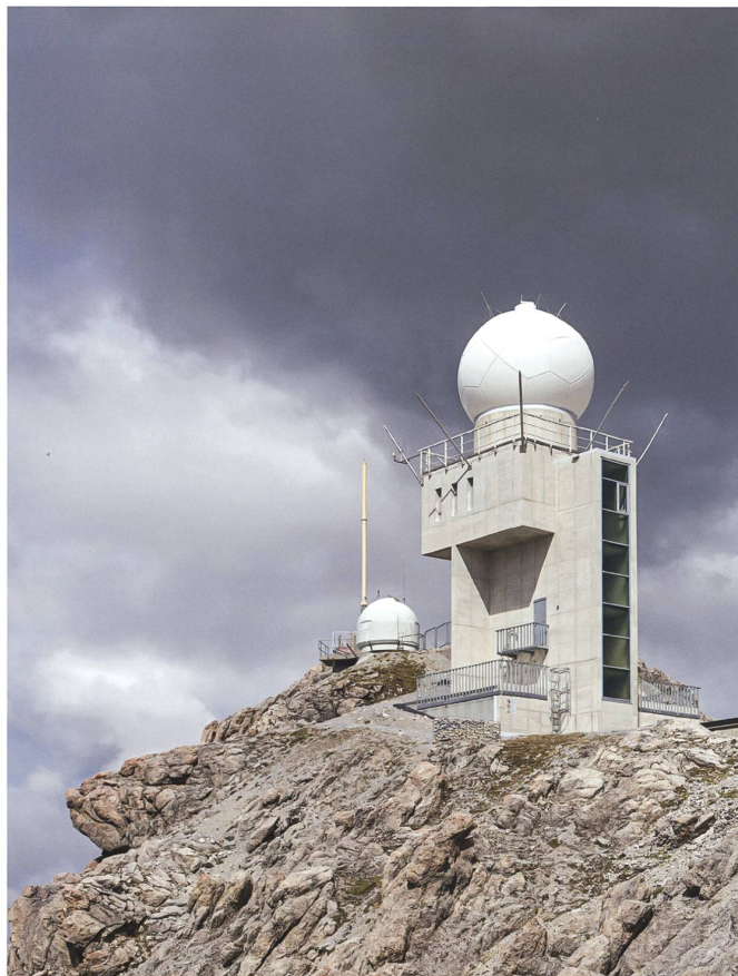
Messen für die Wissenschaft: der 2014 erbaute Wetterraar von MeteoSchweiz auf der Weissflue im Kanton Graubünden mit der charakteristischen Antennenkuppel (Radom). Foto Michael Peuckert
