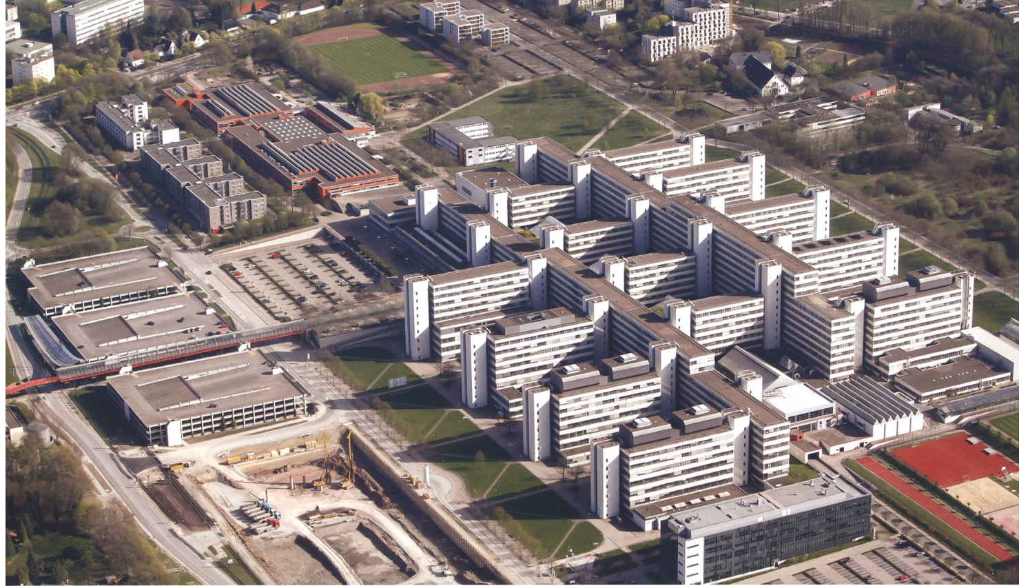
Universität Bielefeld, 1970–1976, Architekten: Manfred Gehrmann, Helmut Herzog, Klaus Köpke, Wolf Siepmann u. Katte Töpfer, Ansicht der Gebäudeanlage. Foto Universität Bielefeld/ commons.wikimedia.org
