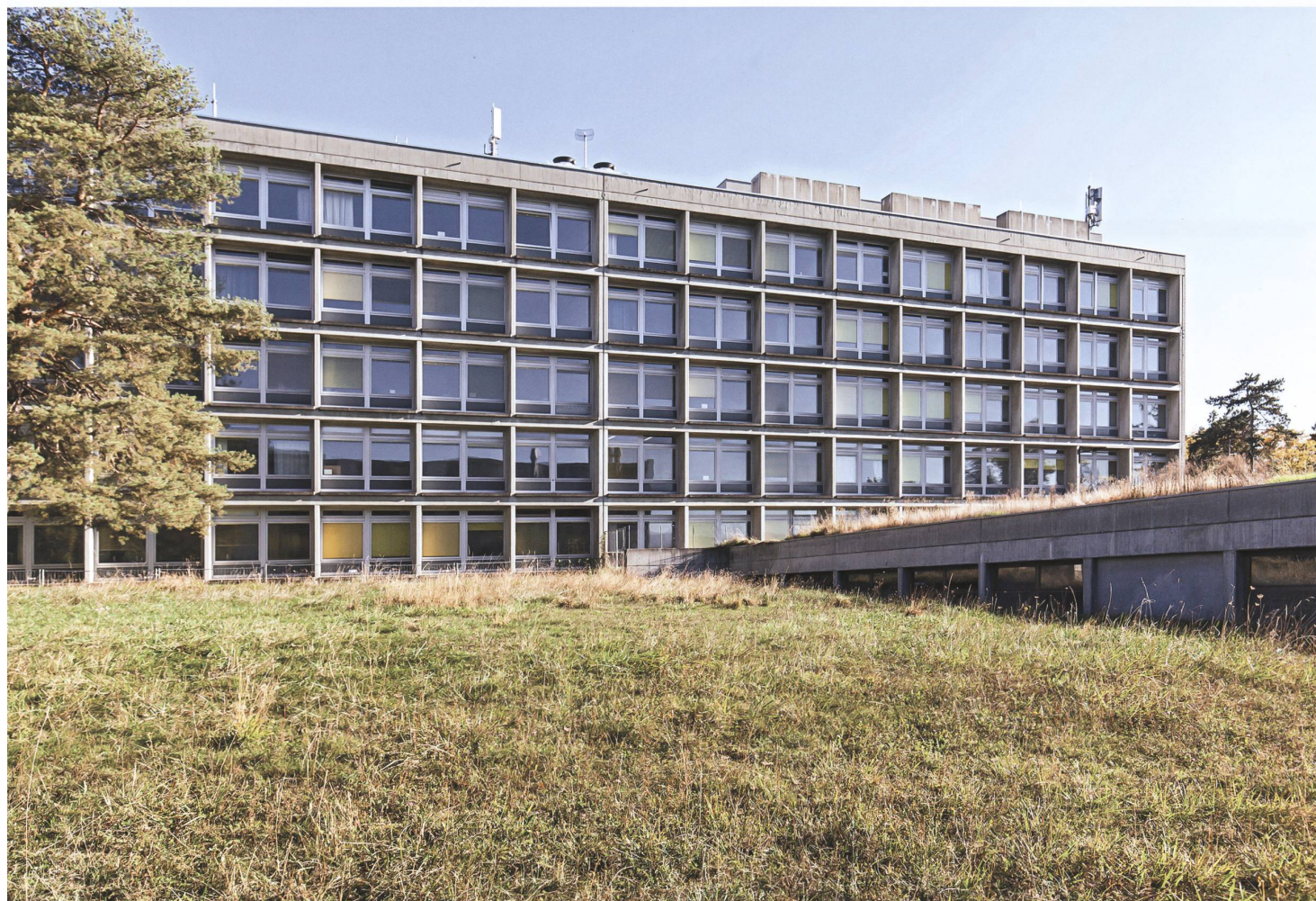
Le bâtiment F et sa structure alvéolaire en béton armé. Photo Michael Peuckert
