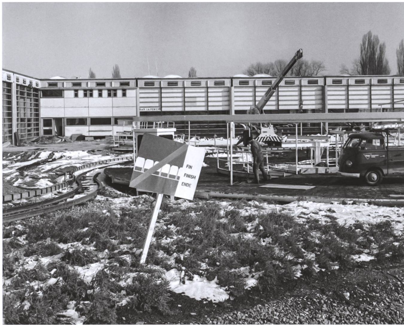
Die Expo 64 im Abbruch, 4.2.1965. Fotograf Erling Mandelmann (Bildarchiv ETH-Bibliothek Zürich)
