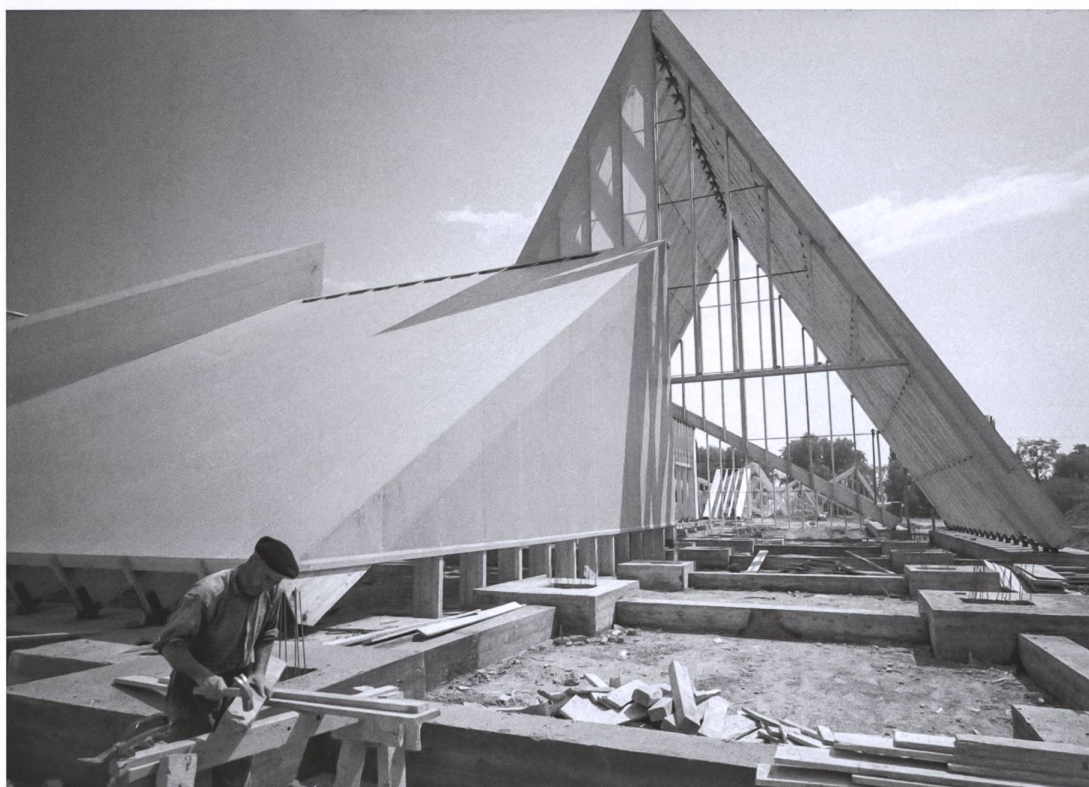
Sektor «Weg der Schweiz» im Bau, 1963. Konstruktion mit verleimten und genagelten Holzbalken und Metallgelenken, die zu dreieckigen Mehrfachbindern verbunden wurden (Bildarchiv ETH-Bibliothek Zürich)
