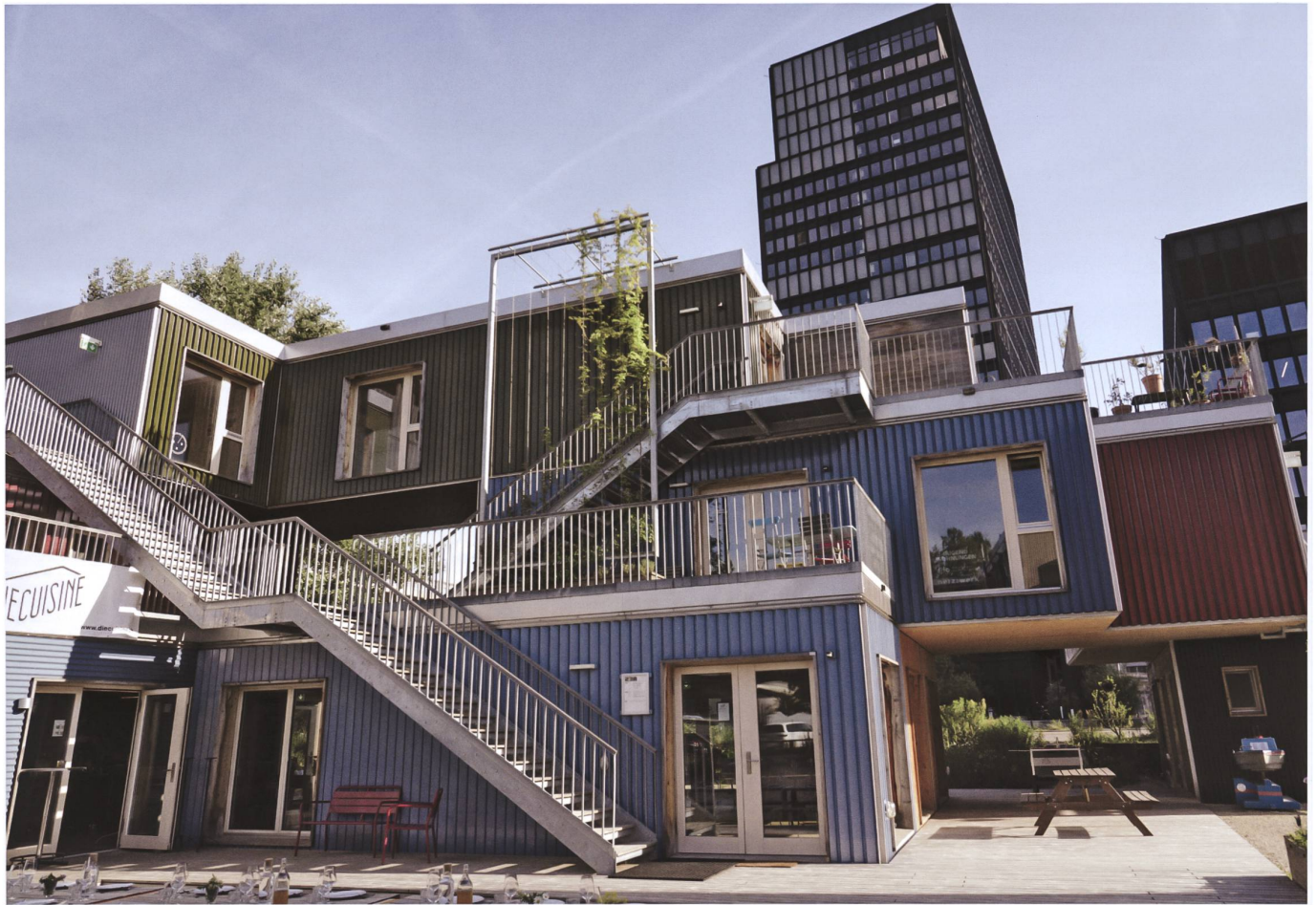
Zürich-Altstetten, FOGO: Die Mantelnutzung spielt mit unterschiedlichen Höhen und erlaubt Durchblicke. Als diaphane Struktur grenzt sie das Areal zur Umgebung ab und funktioniert gleichzeitig als Durchgang in diese. In Kombination mit dem Turm der Westlink-Überbauung ergeben sich interessante Interaktionen unterschiedlicher Höhenverhältnisse. Foto René Uhlmann
