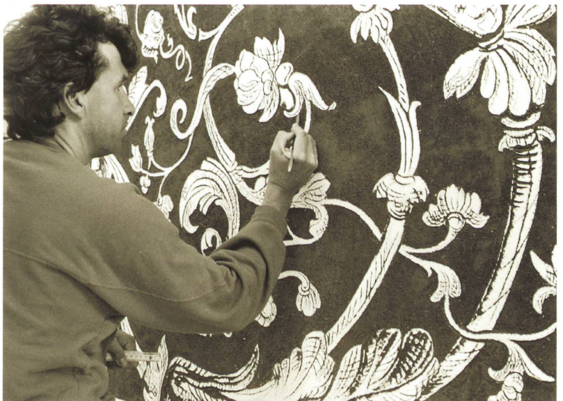
Abb. 8a+b Das Sgraffito der ehemaligen Eidgenössischen Sternwarte in Zürich wurde 1996 durch Stefan Buess und sein Team rekonstruiert, jedoch ohne die Semper'sche Asphaltsschicht, die den Farbkontrast gemildert hatte. © Kantonale Denkmalpflege Zürich
