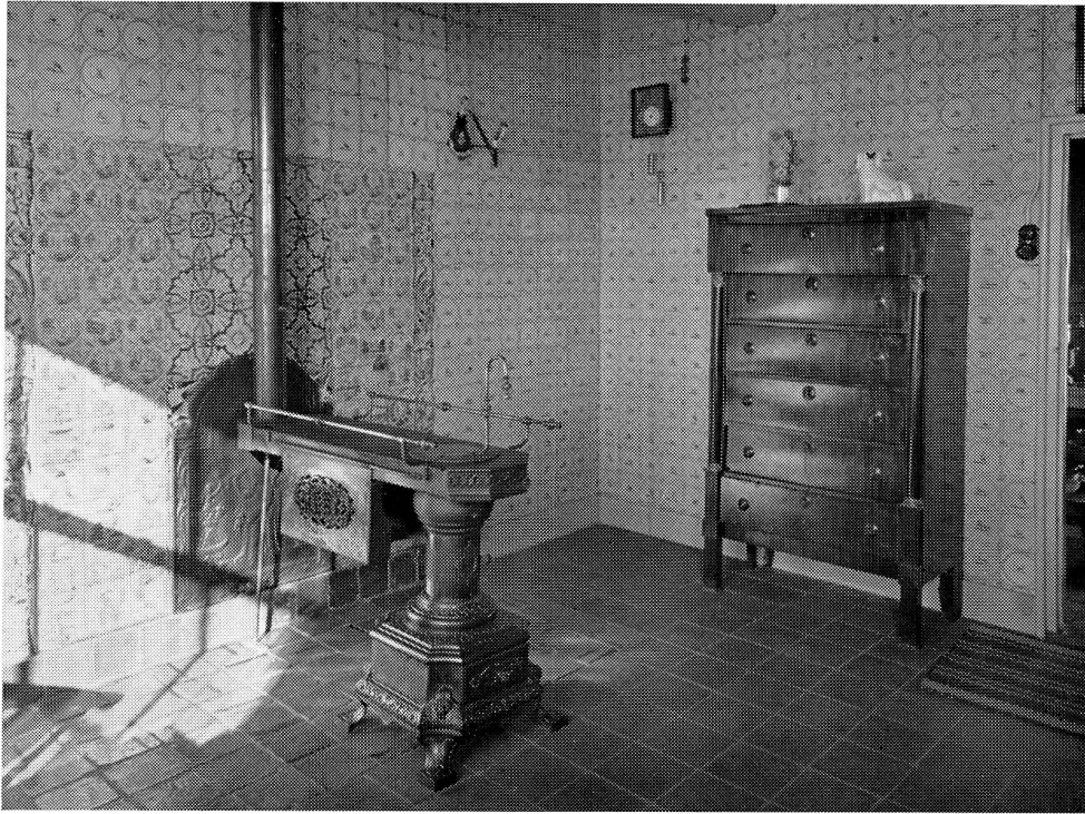
Abb. 2. Interieur des Commandeurhauses nach der Restauration. Die Wände sind, mit Ausnahme der Herdpartie, mit «Springersujets» besetzt.
