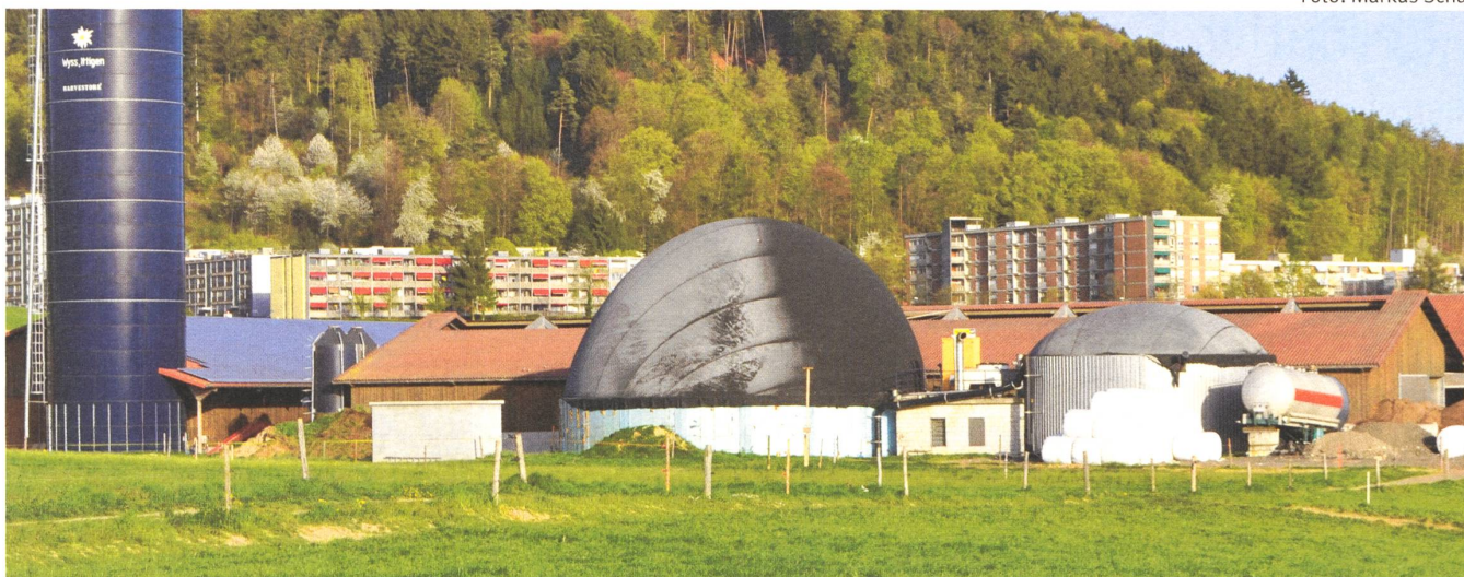
Biogasanlage auf Bauernhof in Ittigen/BE.
