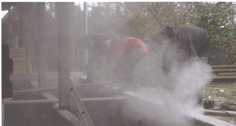
Bauen am Pschüttloch.
