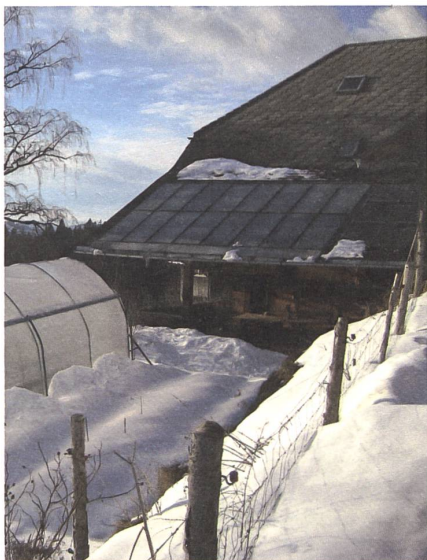
Im Winter sollte der Schnee von den Kollektoren abrutschen können.
