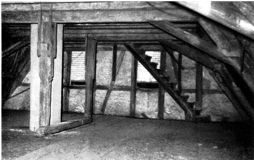
Abb. 6. Trockenboden (einst mit Schnüren bespannt zum Aufhängen der feuchten Papierblätter; alle Fenster und die zahlreichen Dachluken sind offen, um den trocknenden Luftzug einzulassen), Rychmühle im St. Alban-Tal. Fot. P. Tschudin.
