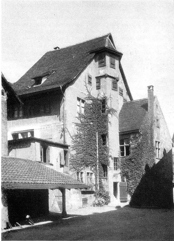
Abb. 5. Die Klingentalmühle. Fot. Öff. Denkmalpflege Basel-Stadt.
