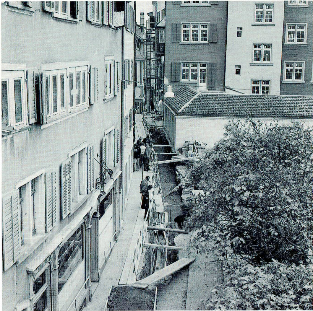
9 Blick im Osten in den geöffneten Leitungsgraben der Spiegelgasse.
