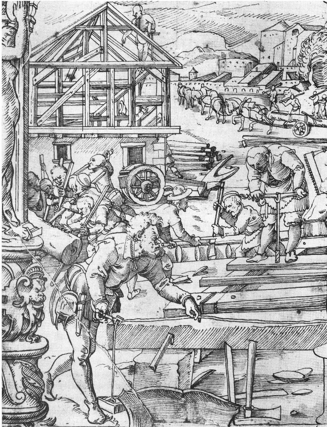
Abb. 16: Zimmerleute bei der Arbeit mit ihren wichtigsten Werkzeugen: Äxte, Holzbohrer («Näpper»), Bundhaken, Schlagschnur (zum Markieren einer geraden Schnittlinie), Handsäge, Hebeisen (oder Kehrhaken); im Hintergrund Fuhrleute mit Pferden und Spezialfuhrwerk beim Rücken eines Baumstammes. — Scheibenriss (Ausschnitt) von einem anonymen Meister um 1600, Schweizerisches Landesmuseum Zürich, LM 24733 (Photo: SLM).
