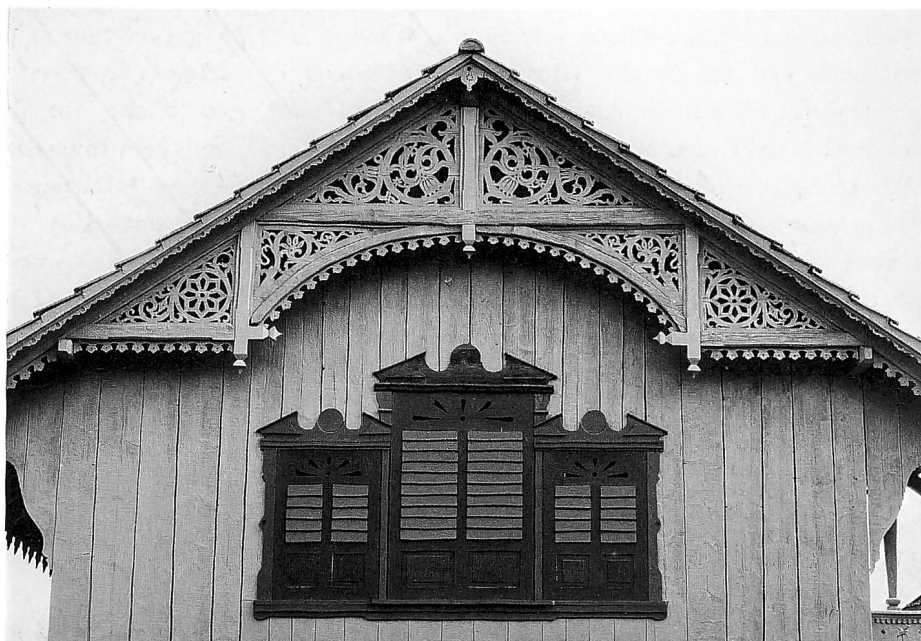
Aussenansicht des Schopfs und reich gestaltete Zierverschalung am Giebeldreieck. Aufnahmen 1993. (Fotos Kantonale Denkmalpflege Zürich)
