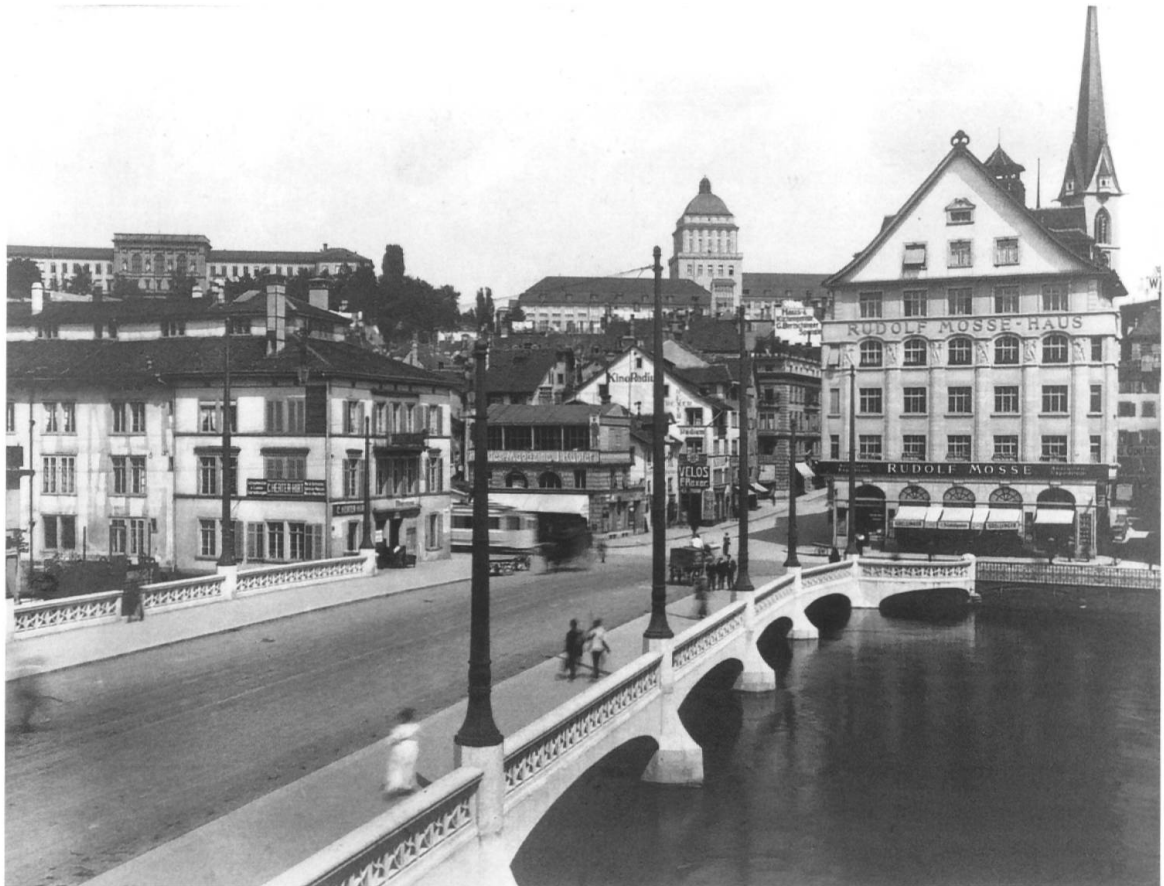
Abb. 12: Uraniabrücke (1912/13) und Mosse-Haus (Bischoff & Weideli, 1911–1913), Aufnahme wohl kurz nach der Fertigstellung.
