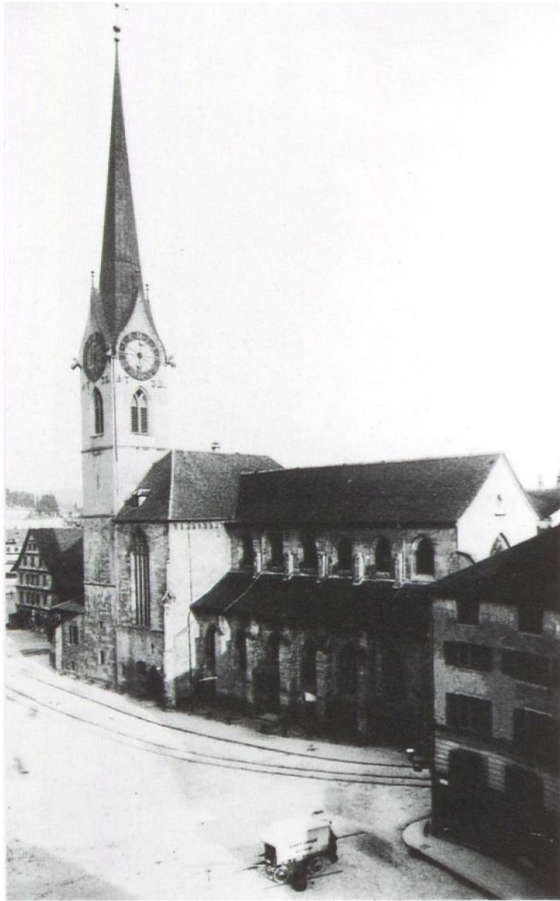
Abb. 9: Alte Fassade zum Münsterhof. Das Gleis vor der Kirche verrät, dass hier noch das Rössliträm vorbeiführ. (Foto: Robert Breitinger, 10. Juli 1895, Baugeschichtliches Archiv der Stadt Zürich)
