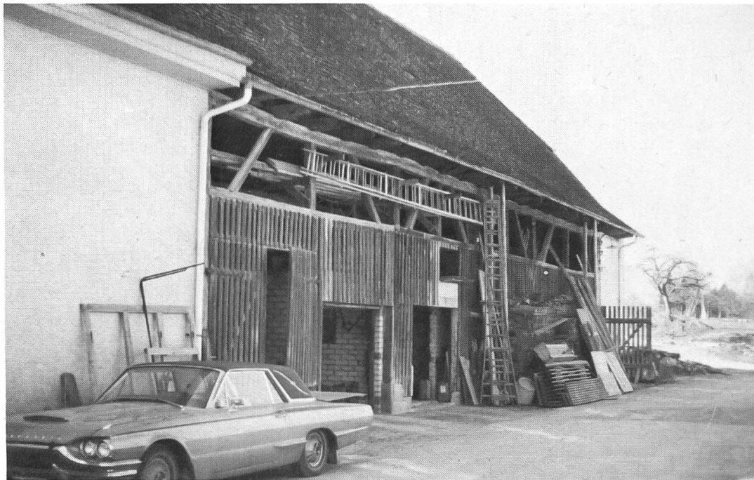
Altes Ökonomiegebäude, Nordseite. Während der letzten 20 Jahre waren hier nebst dem Holz auch die Schweine, Metzgerei, Autogaragen, Bauhütte und ein Geräteschuppen für die Bezirksschule untergebracht.
