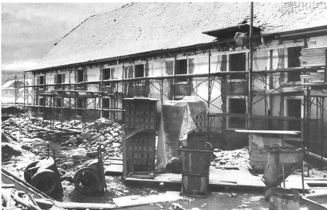
Altes Ökonomiegebäude, Südseite. Die Fenster der Zimmer werden eingebaut.
