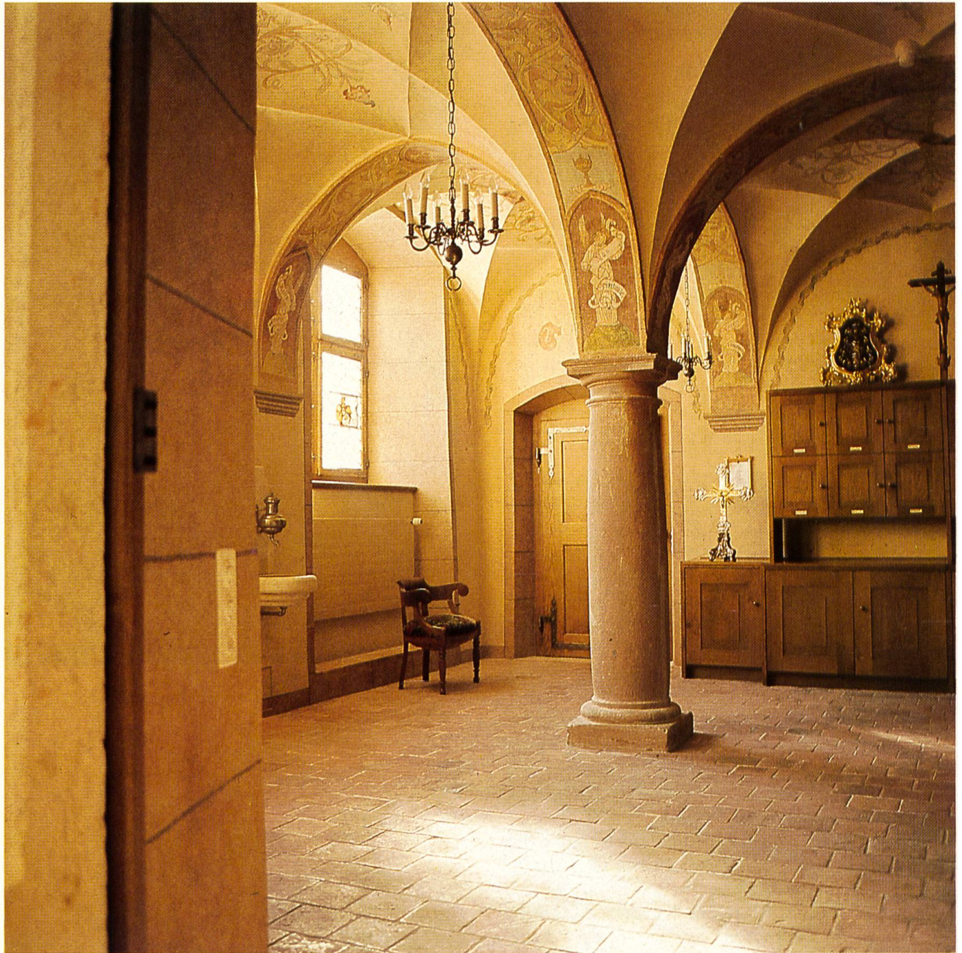
Sakristei, Rautengewölbe. Pflanzenornamentmalerei. Die einzelnen Formen, Farben und Blüten wiederholen sich über die ganze Decke, darum liessen sie sich leicht ergänzen und retuschieren.
