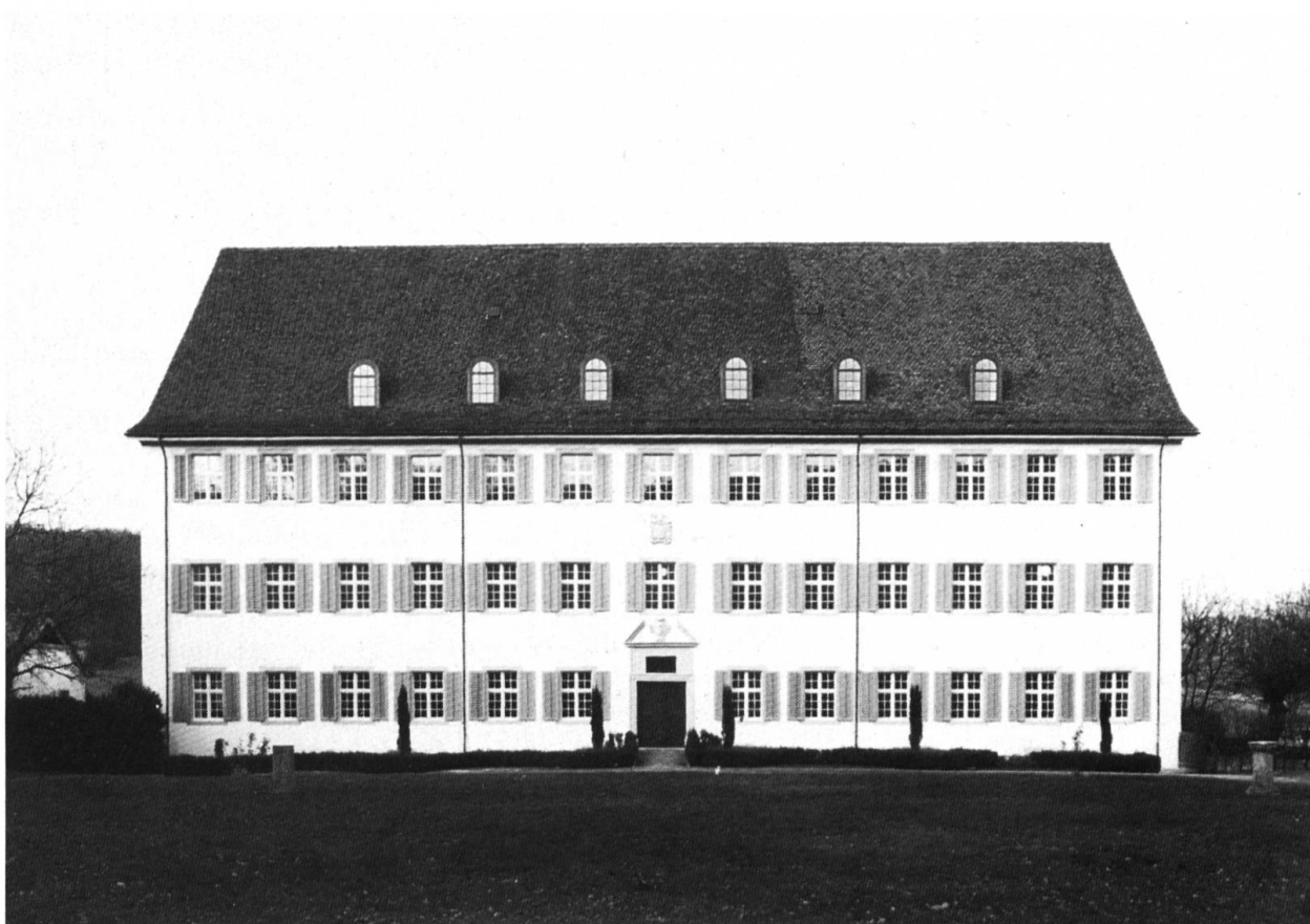
Südfassade mit den neuen Dachgauben.
