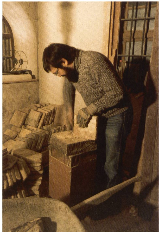
Einer, der selbst Hand anlegt: P. Bonifaz beim Säubern von Bodenplatten während der Renovierungsarbeiten im Kloster (1979).
