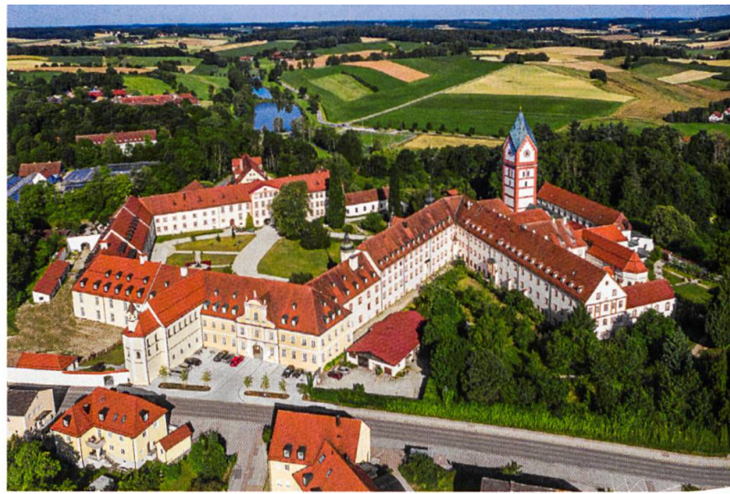
Der aussergewöhnliche Grundriss der Klosteranlage.
