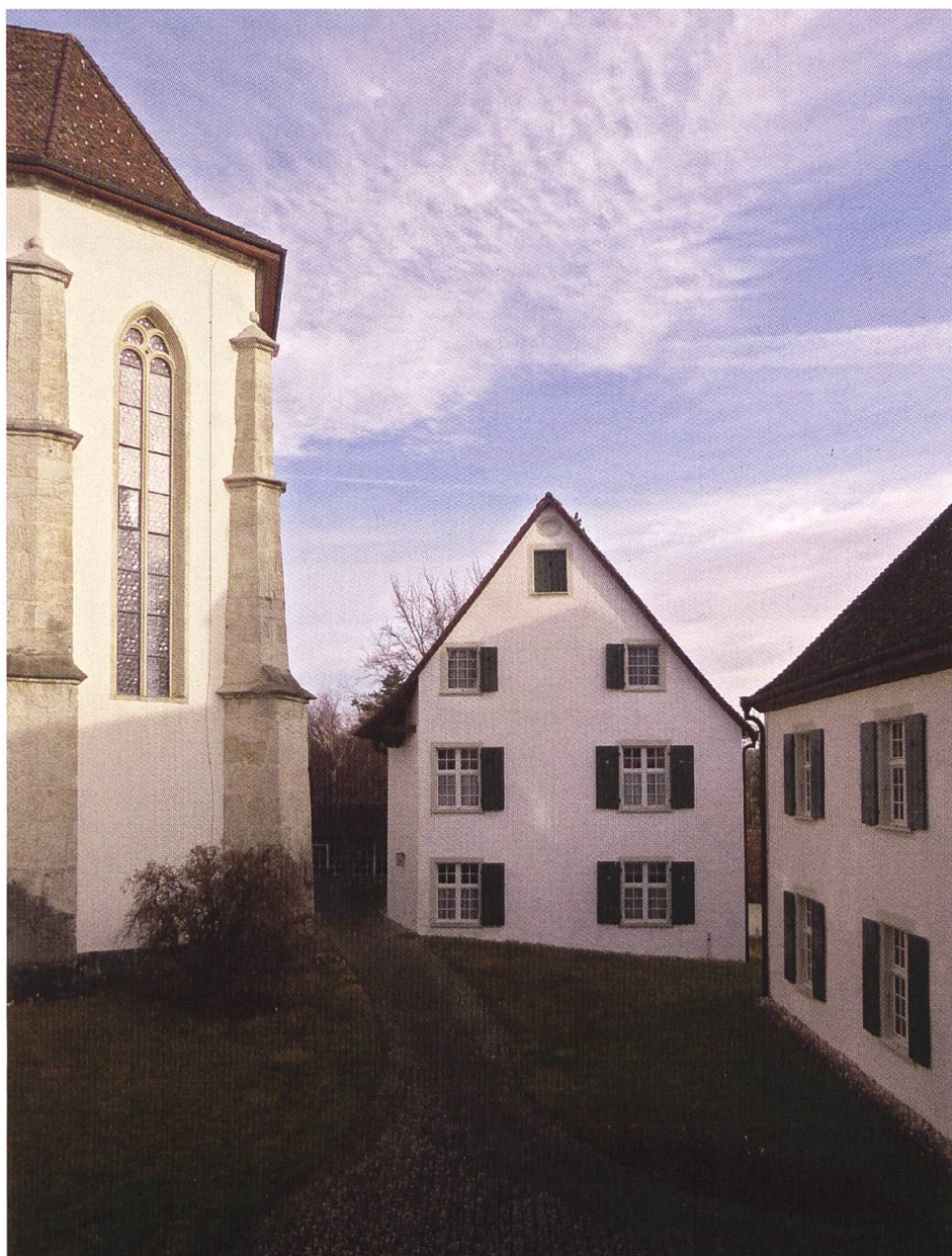
Das Gertrudisheim zwischen Basilika und Glutzbau.
