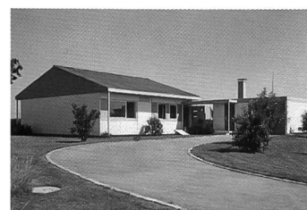
Maison familiale du directeur de la fabrique de Fontainemelon, réalisée avec des éléments préfabriqués issus de l'usine Igéco.
