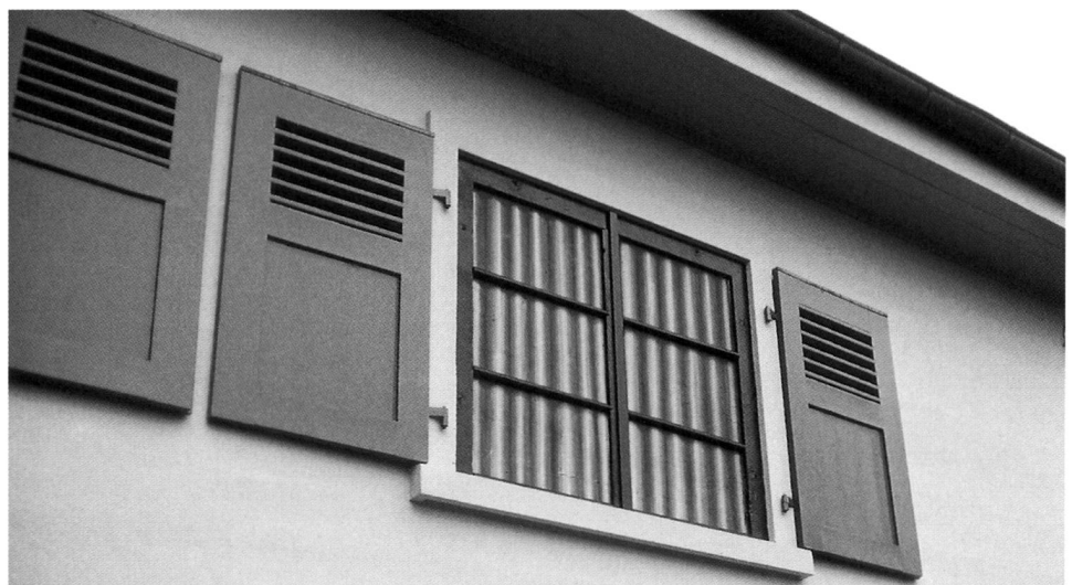
"Villa rose" après sa rénovation, détail de la fausse fenêtre, novembre 1999.
