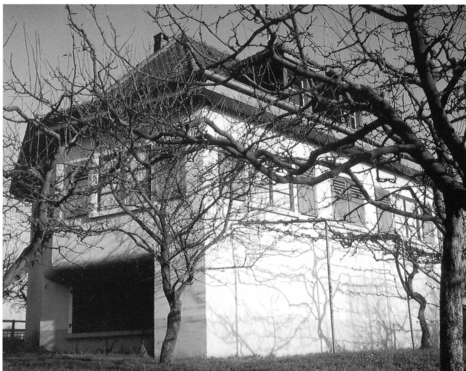
“Villa bleue” après sa rénovation, janvier 1998.
