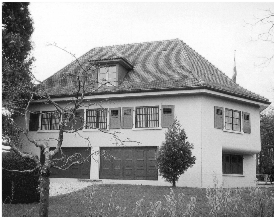
“Villa rose” après sa rénovation, novembre 1999.
