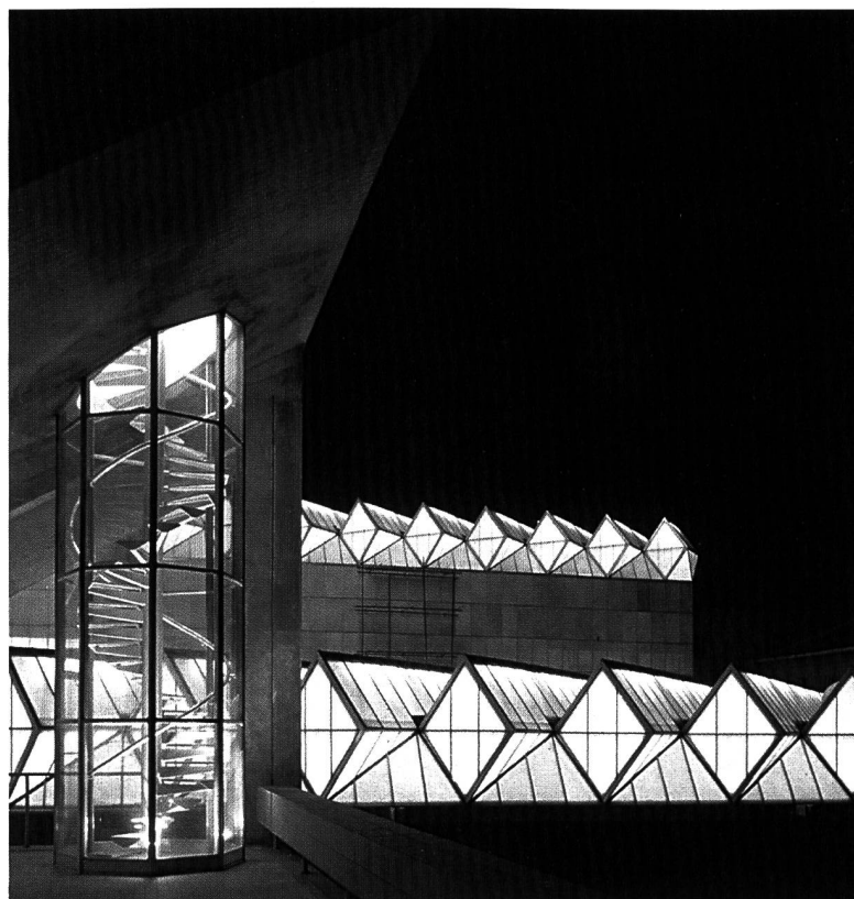
Leicester, l'image "cristalline" dégagée de la vue nocturne de l'escalier en colimaçon qui mène aux amphithéâtres et, au fond, la verrière des ateliers.
