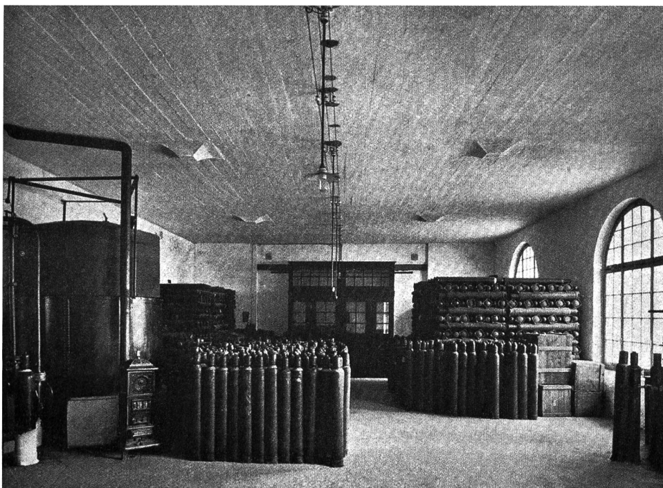
Bâtiment de la Société suisse d'acide carbonique (1911-12). Plancher champignon "suspendu".
