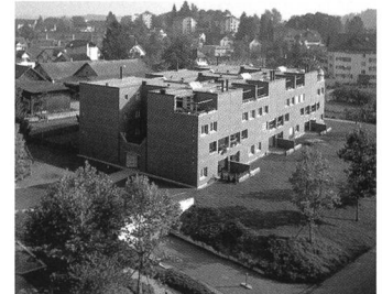
Michel Roux-Spitz, immeuble rue Guynemer à Paris, 1925.
