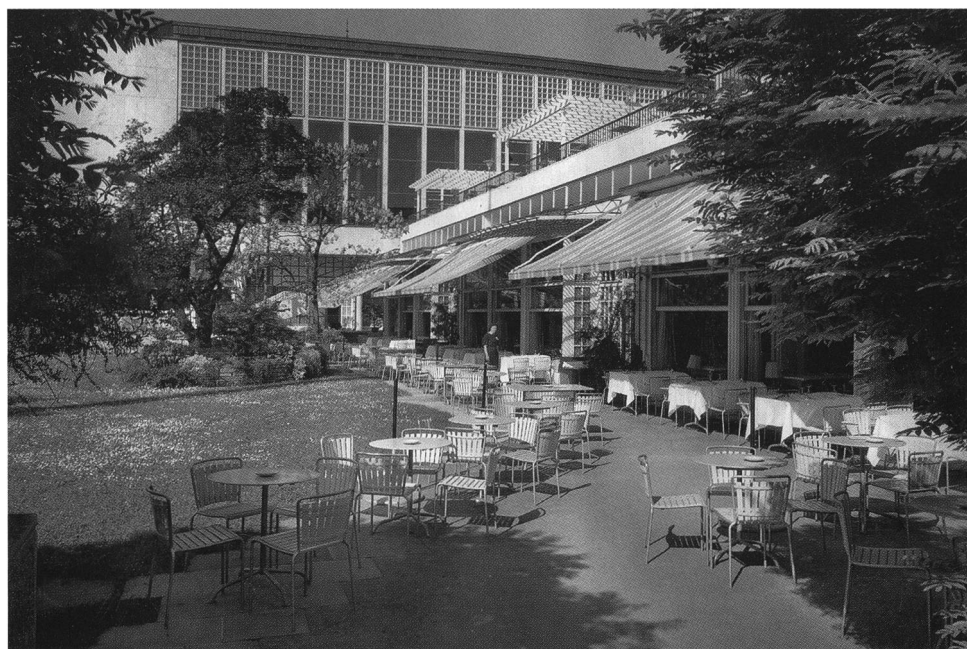
Haefeli-Moser-Steiger, Palais des congrès à Zurich, 1937-1939 (Document: Wolf Bender, Baugeschichtliches Archiv der Stadt Zürich).
