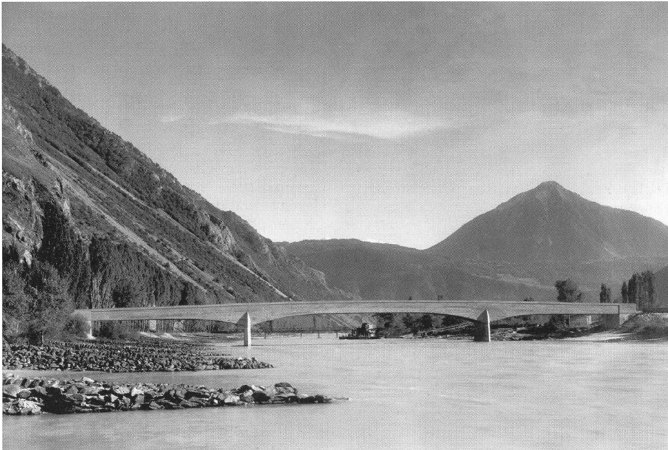
Pont sur le Rhône à Dorénaz (1932-1933), photographie retouchée (fonds d'archives Alexandre Sarrasin, EPFL - ACM).
