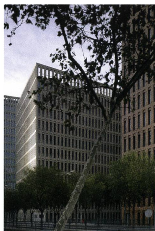
(gauche) David Chipperfield associé à Fermín Vázquez - b720 Arquitectos, palais de justice de Barcelone et L'Hospitalet de Llobregat, 2002-2009.
