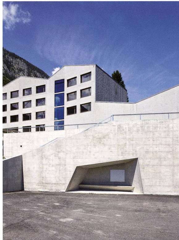
Bonnard & Woeffray, école de Salvan, canton du Valais, 2016. Vue des terrasses.
