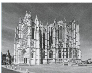
Le chœur et le transept de la cathédrale de Beauvais.
