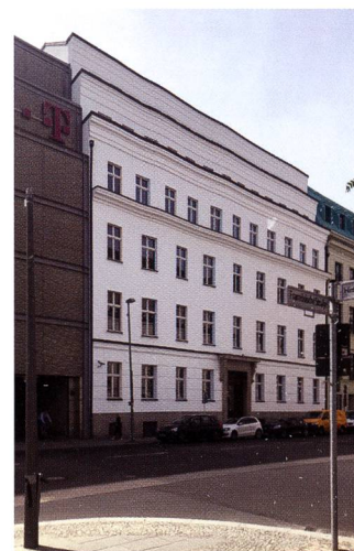
Immeuble de la Französische Strasse 32, d'Otto Ortel, surélevé par Hans Kollhoff, 1999.
