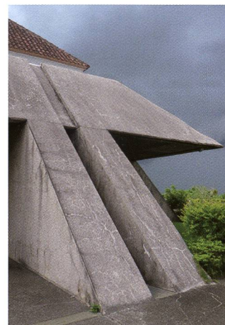
Détail des angles et des gouttières. Relation entre intérieur et extérieur.
