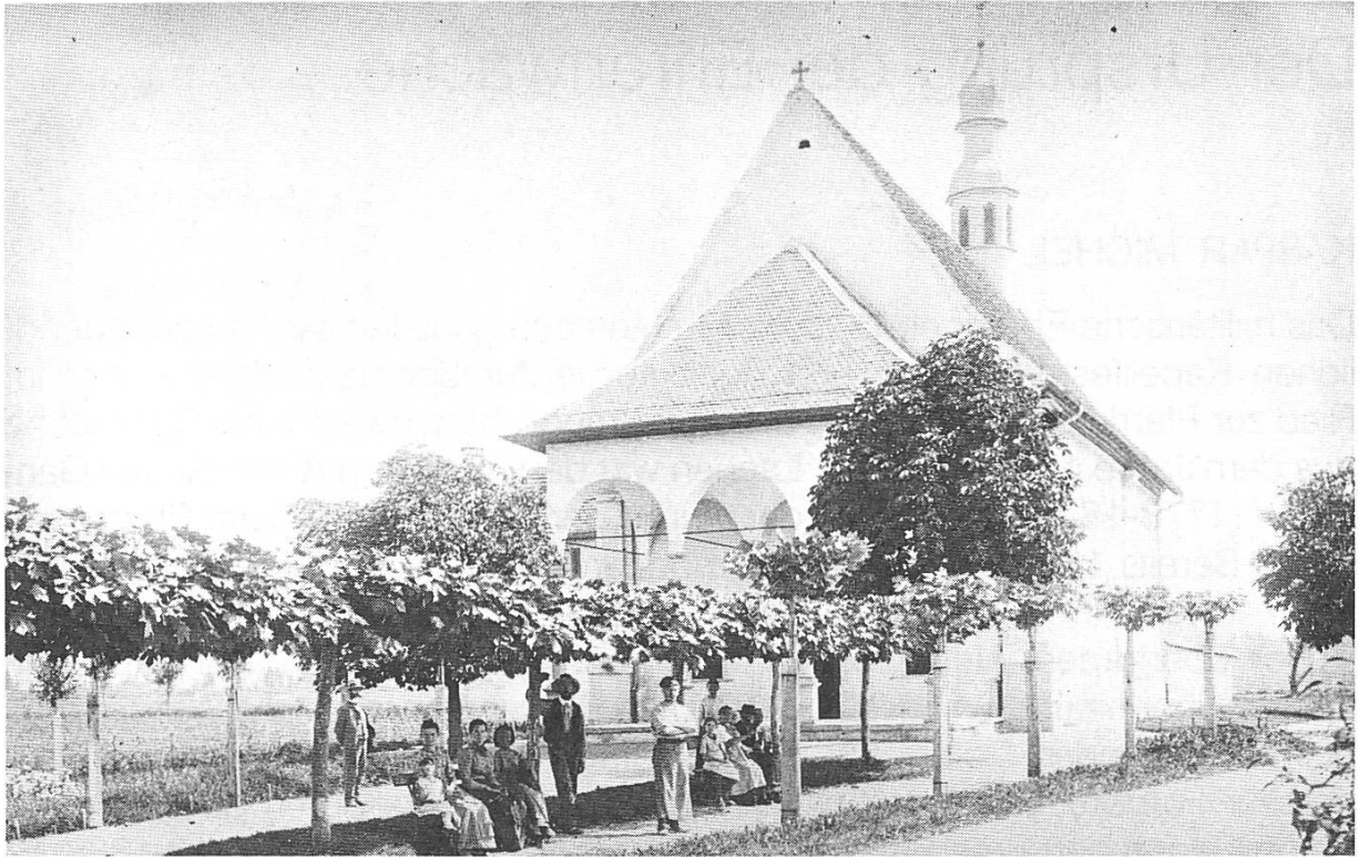
Nach der Renovation von 1889-1895, mit der neuerstellten Platanenallee im Vordergrund, Foto um 1900, Slg. Kaspar Michel, Lachen.
