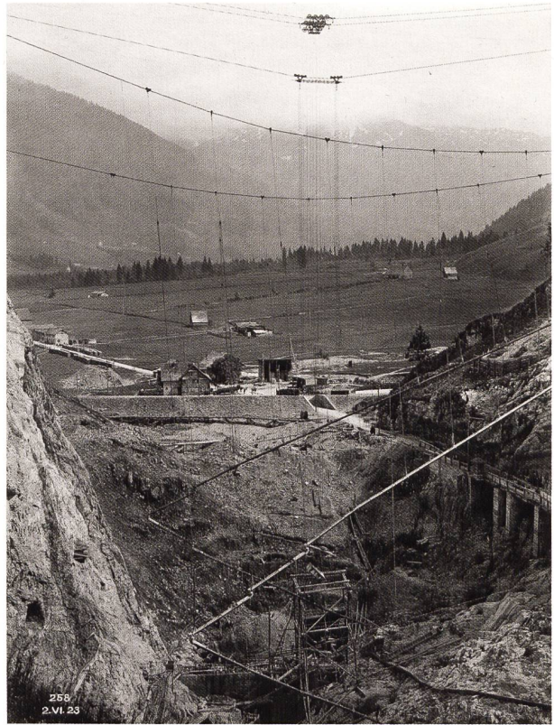
1923 wurde mit den Betonierungsarbeiten für die grosse Staumauer im Schräh begonnen.
