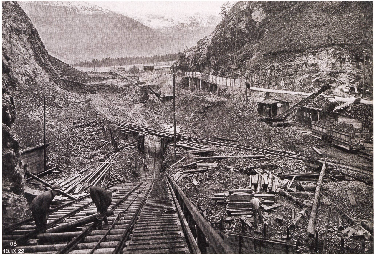
1922 wurden Transportgeleise für die Bauarbeiten an der grossen Staumauer im Schräh eingerichtet.
