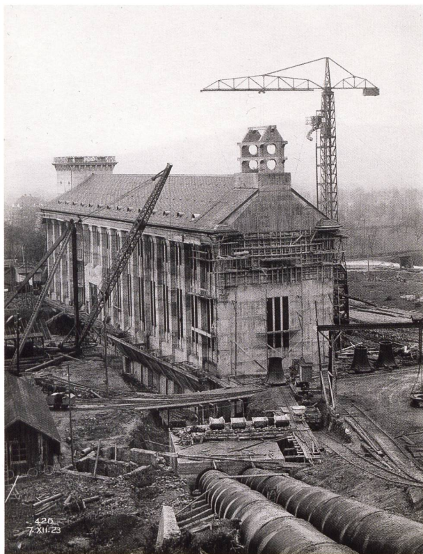
Die Bauarbeiten für das Maschinenhaus in Siebnen sind im Dezember 1923 bereits weit vorangeschritten.
