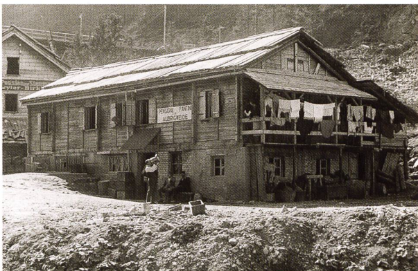
Viele Arbeiter waren in einfachen Baracken untergebracht.
