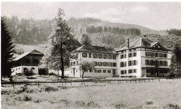
Das Kurhaus Bad Wägital wurde von der Stadt Zürich für den Bau der Kraftwerkanlage erworben.
