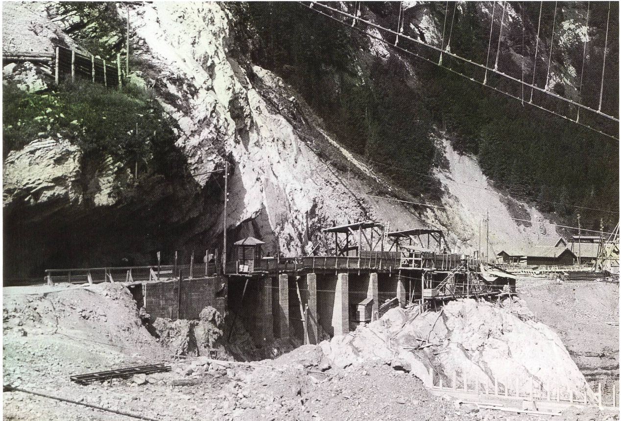
Eine Aufnahme aus der ersten Bauphase im Bereich Schräh im Jahr 1922.
