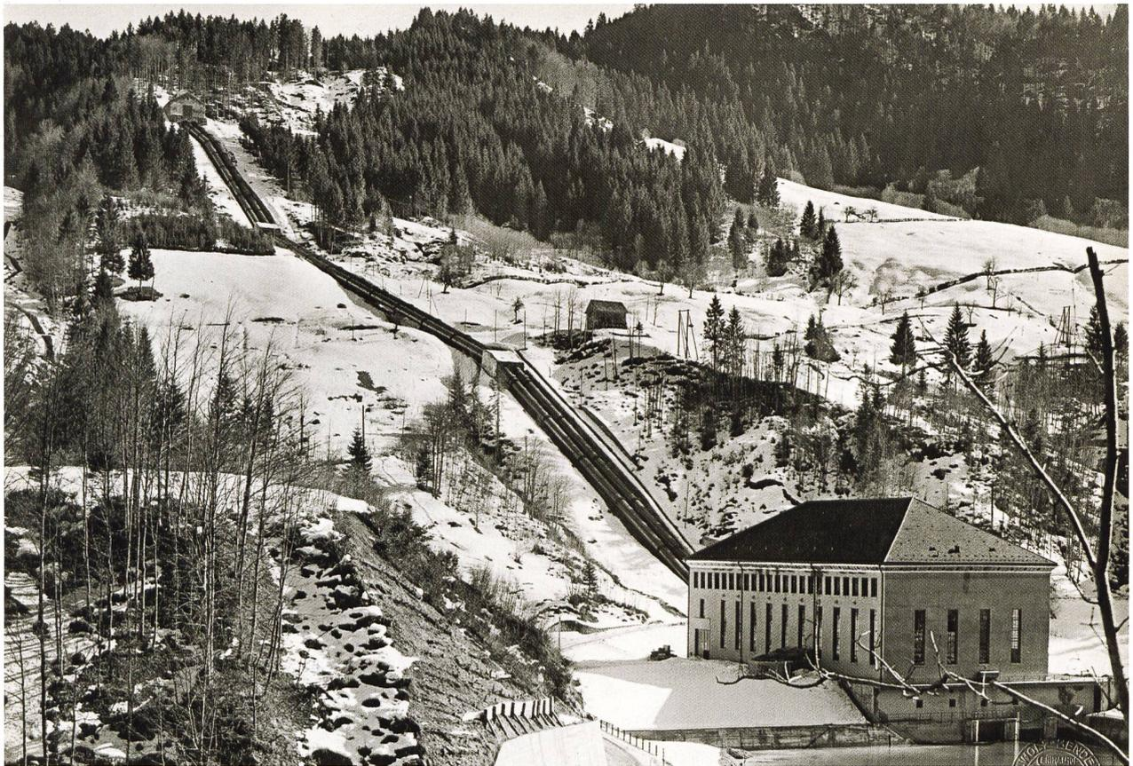
*Das fertiggestellte Maschinenhaus in der Zentrale Rempen mit der imposanten Druckleitung.*
