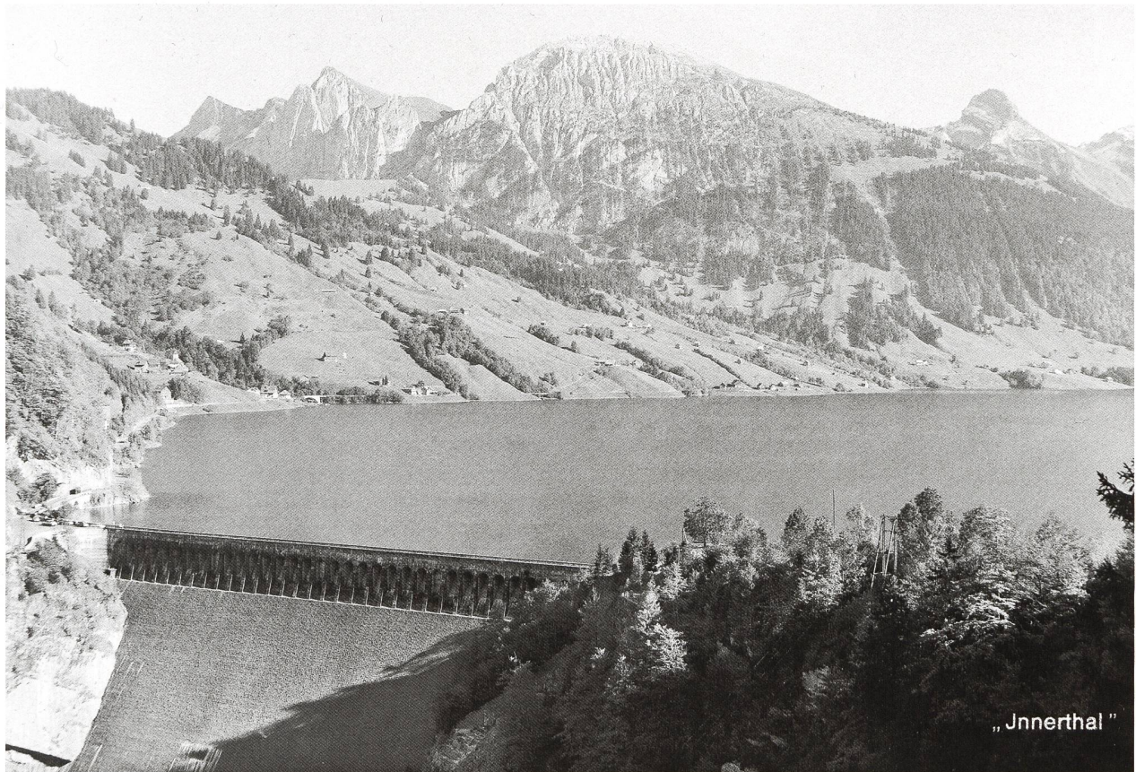
Stausee und Staumauer Schräh nach der Fertigstellung 1925: links der Blick auf neu Innerthal, im Hintergrund (von links) Tierberg, Bockmattli, Schwarzenegg, Schiberg, Zindelspitz und Lachenstock.
