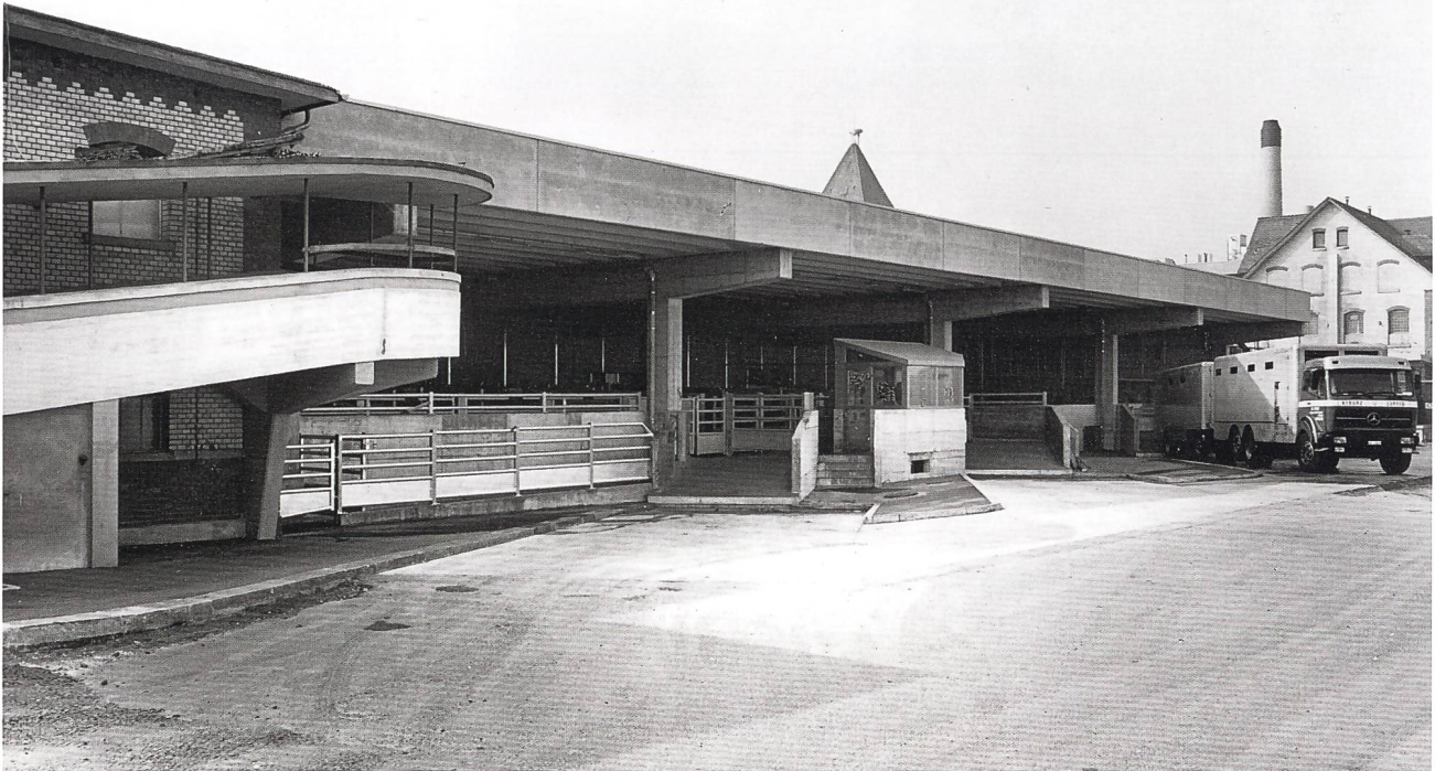
Schlachthof Zürich, Neubau 1985, Nordseite mit unterschiedlichen Rampen für die Viehanlieferungen. Links die bestehenden Ställe für Grossvieh. Die Anlieferung mit der Bahn wurde stillgelegt.
