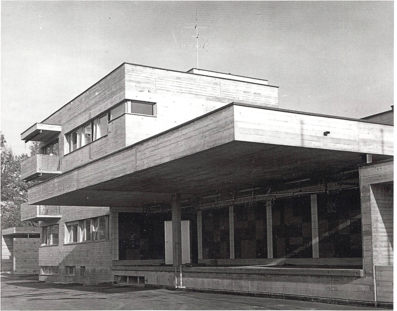
Zentralschlachthof in Hinwil, Neubau 1967, rechts die Auslieferung, links der Büro- und Sozialtrakt mit zwei Wohnungen.
