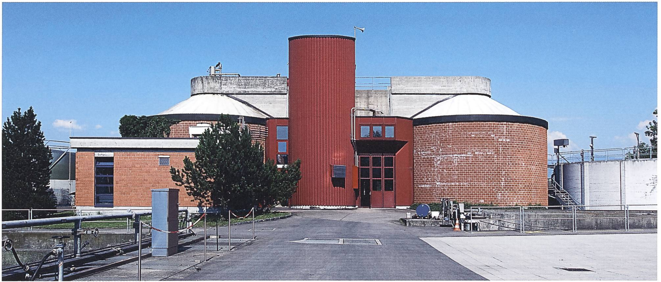
ARA Untermarch, Faultürme mit Ergänzungen für die Frischschlamm-Hygienisierung, 1989.
